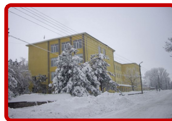
L'école secondaire rénovée
