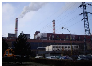
La station de production de chaleur de TEKO
